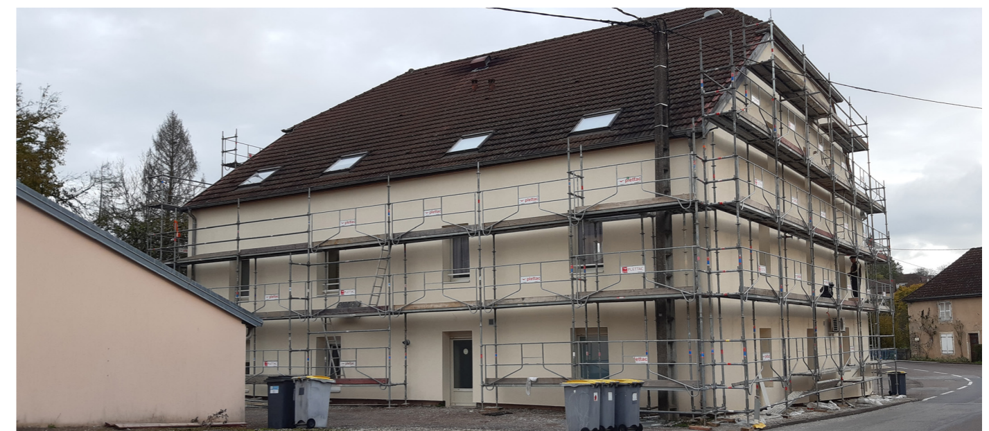
Travaux d'isolation thermique à Loulans-Verchamp
